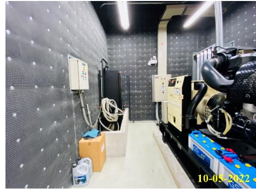
ภาพที่ 2.2-28 เครื่องกำเนิดไฟฟ้าสำรอง
