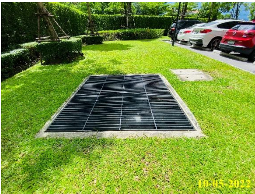
ภาพที่ 2.2-25 ตะแกรงดักขยะ
