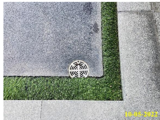
ภาพที่ 2.2-61 ตะแกรงครอบรูระบายน้ำ
